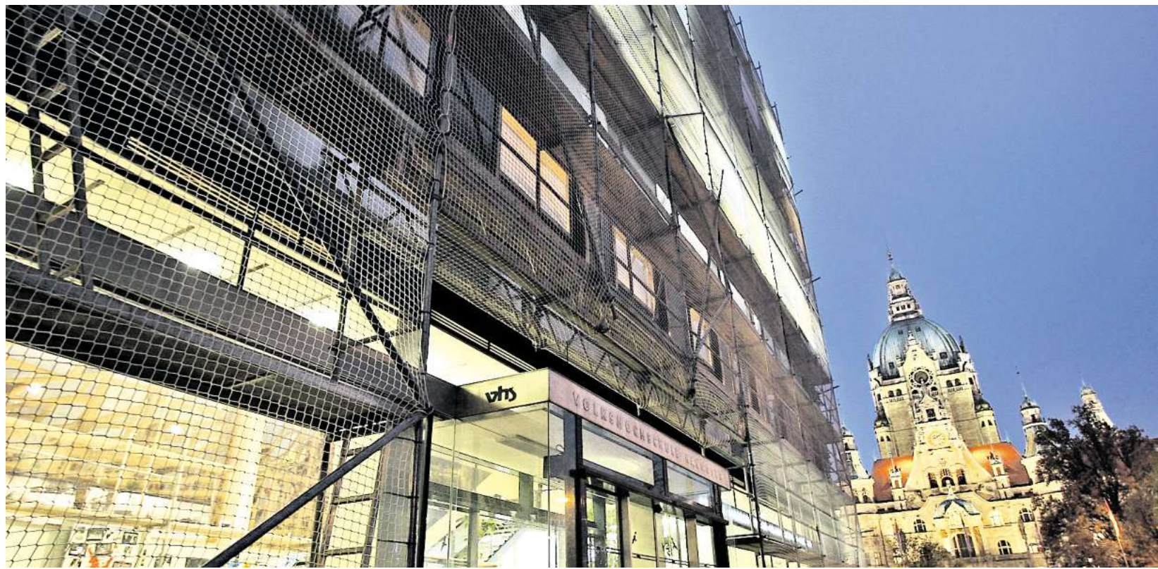
Die Sanierung hat begonnen: Ehemaliges Volkshochschul-Gebäude am Theodor-Lessing-Platz gegenüber vom Neuen Rathaus.
