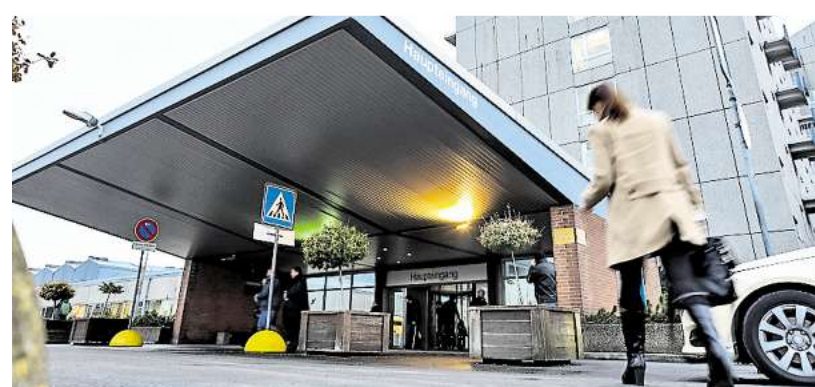
„Die Abläufe sind nicht in Ordnung“: Die MHH hat Probleme beim Bauen.
