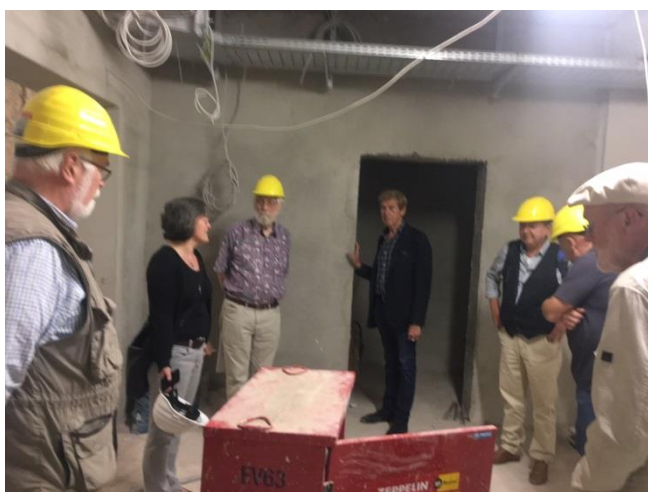
Edel Sheridan-Quantz (2.v.l.) malt die Baustelle sprachlich aus. Foto: Karljosef Kreter
