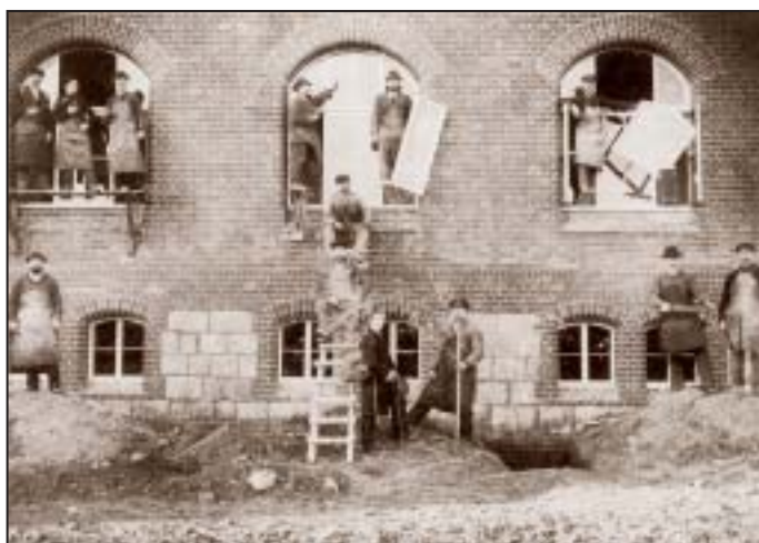
Handwerker bei Bautätigkeiten an der Heil- und Pflegeanstalt Lüneburg
